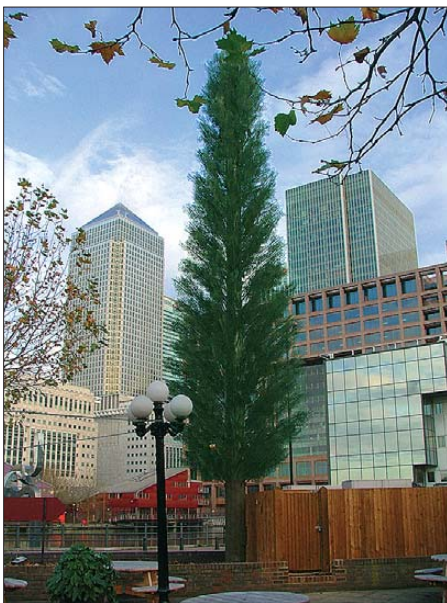
Bild 1: Getarnte Sendemasten – wie dieser Nadelbaum – sollen Panik vor den möglichen Risiken der Mobilfunktechnologie vermeiden helfen. Quelle: Francis & Lewis Ltd./dmD Designmaste Deutschland GmbH
