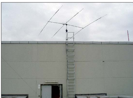
Der an einer Leiter fixierte Dreielementbeam für 20 m, 15 m und 10 m. Fotos: OE3SGU
